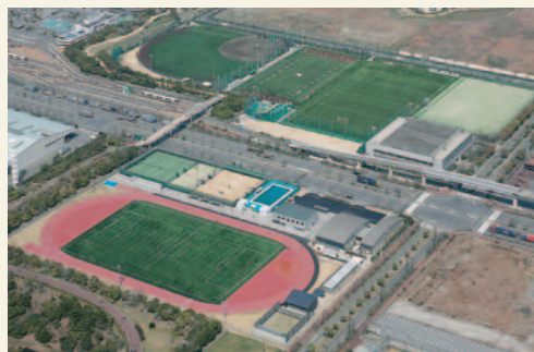
六甲アイランド総合体育施設
