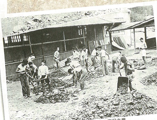
▲昭和13年の阪神風水害で被害を受けた校舎の復旧作業
