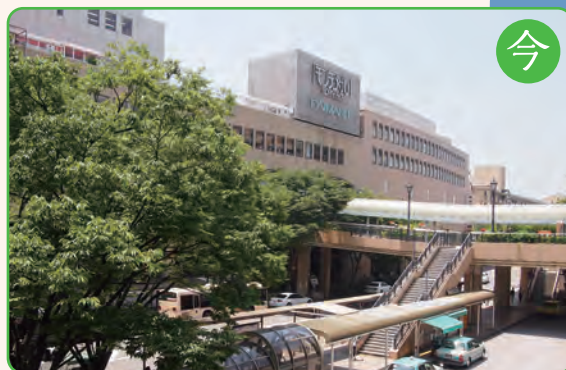
現在は橋上駅舎で、駅北側には商業施設「モンテメール」が直結。
