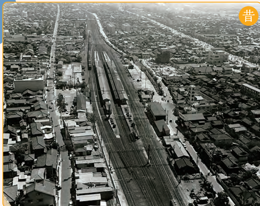
再開発前の風景。国鉄芦屋駅を挟み、北(写真左)も南(写真右)も低い屋根がひしめく。
