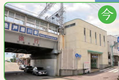
北側ホームにのみ窓があり、 冬の六甲おろしを防いでいる。
