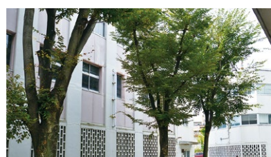
解体前の旧理系棟(15・16号館)
