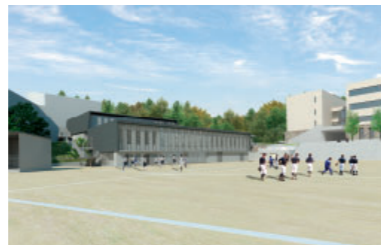
新体育館の外観
