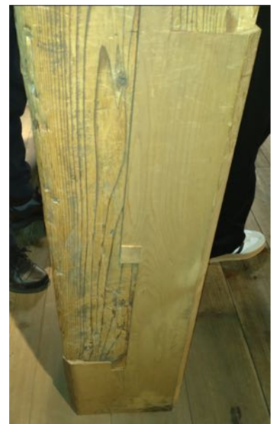
図-4 修復された心柱 左側は補修前、右側は新しいもの。 新しい方が若干大きい。複雑な継ぎ方に大工の苦勞を感じる。
