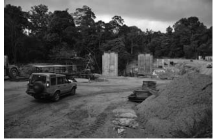
写真13 観光化にあわせて進められる道路建設工事（2012年9月）
