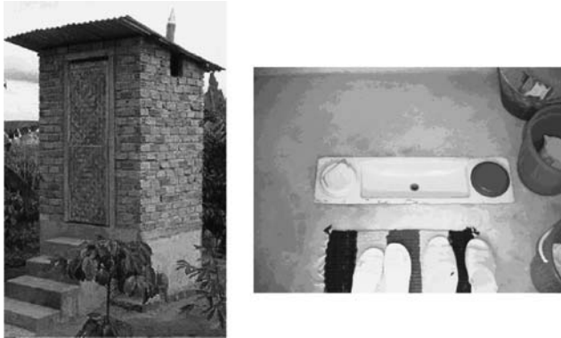
写真3 し尿分離トイレにより灰を用いた大便の処理・農業利用を実現（ベトナム）
